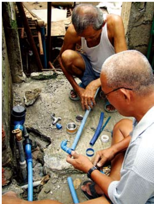
在马尼拉Alitaptap社区安装仪表管网
